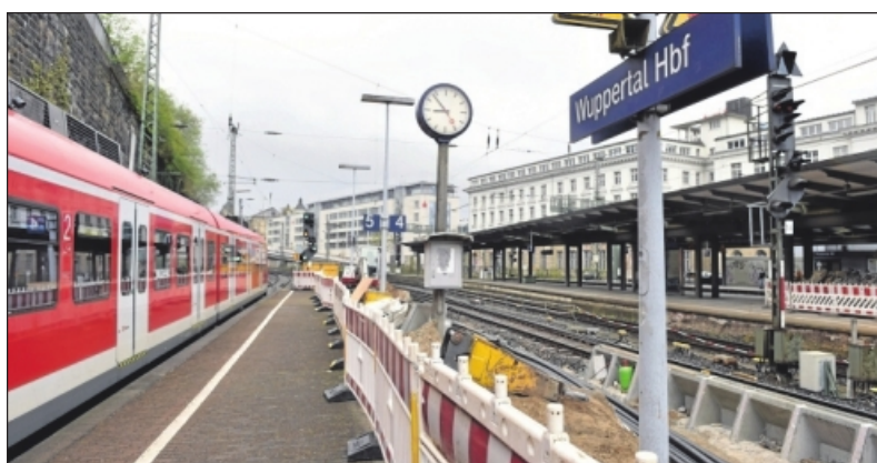
Bauarbeiten schränken derzeit den Bahnverkehr im Wuppertaler Hauptbahnhof ein.
